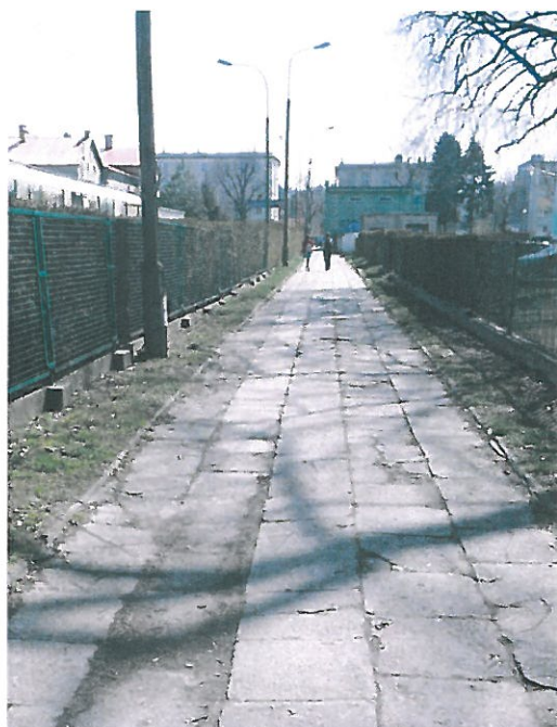
Ul. Ofiar Oświęcimskich przed przebudową
